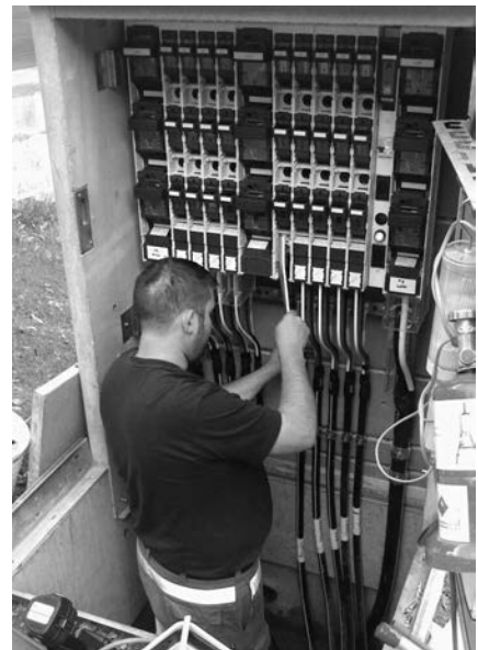
Daniel Megert beim Anschluss der neuen Verteilkabine Lehn, Wengen
