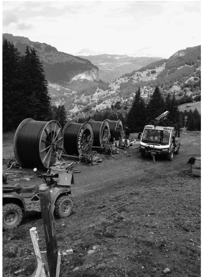
Kabelzugarbeiten für die Jungfraubahnen, neue Verkabelung Umformer Wengen bis Wengernalp
