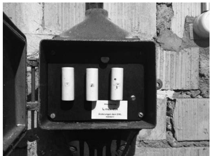
Ein Relikt «alter Hausanschlusskasten»
