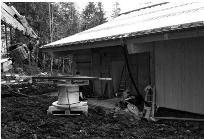
Neubau Werkhof Gemeinde, Trafostation Lücke, Wengen
