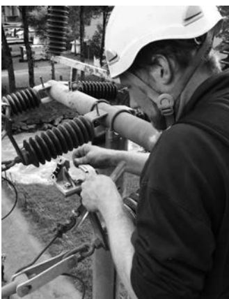
Markus Oehrli repariert einen Hochspannungstrenner einer Freileitung
