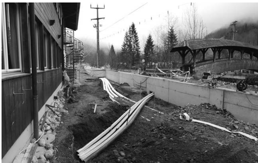
Neue Leitungsführung, Hochwasserschutz Weid, Lauterbrunnen
