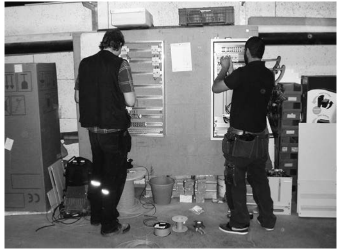
Nik Fahrni und Marko Djuricic bei einer Verteilerverdrahtung
