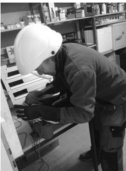
Marc Hubacher bei einer Kurzschlussmessung
