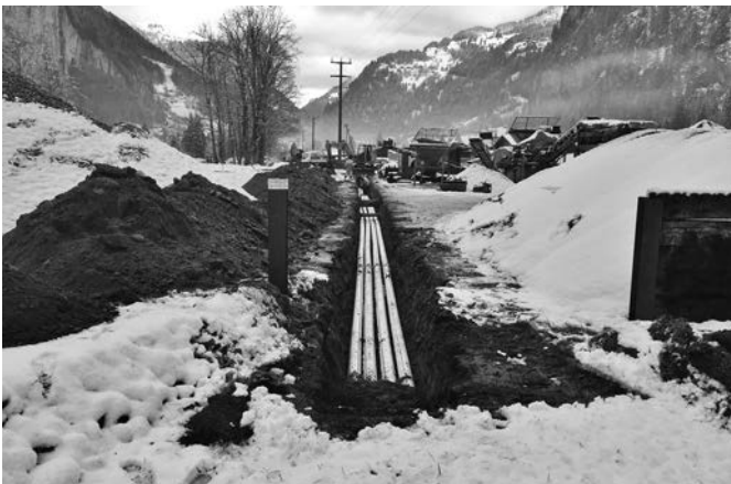
Erdverlegung der Freileitung, Hochwasserschutz Weid, Lauterbrunnen
