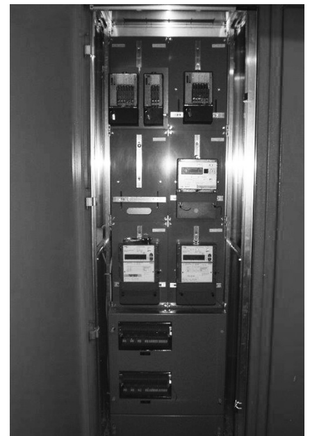
Messeinrichtung in einer Kundenanlage
