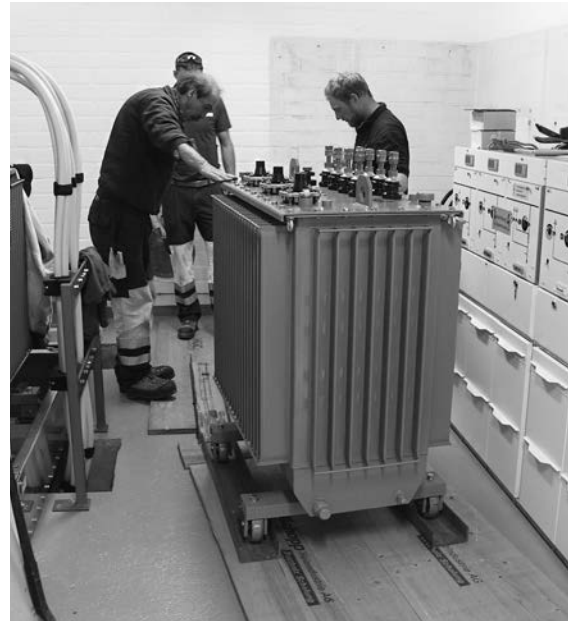
Mitarbeiter der Netzgruppe beim Umbau der TS Fuhren, Lauterbrunnen
