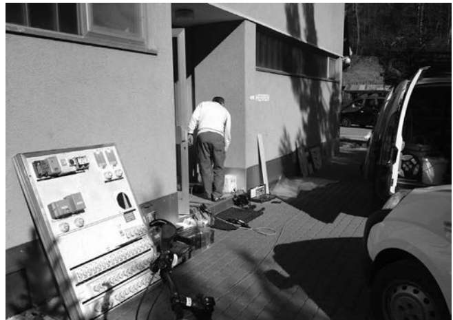
Baustelle Sekundarschulhaus Lauterbrunnen
