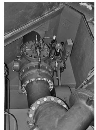
...und der neue Kugelhahn ist fertig eingebaut
